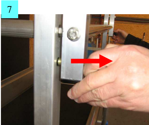
4. Positionner et fixer les équerres du plateau Minipli aux 2 échelles. L'échelle d'accès est légèrement penchée pour faciliter l'accès.
