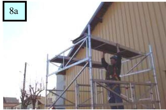
Mettre en place 2 plateaux pour le montage ( fig. 8 et 8 a )
