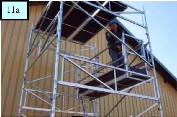
Pour le plateau de travail mettre en place le plateau à trappe au-dessus du plateau inférieur
