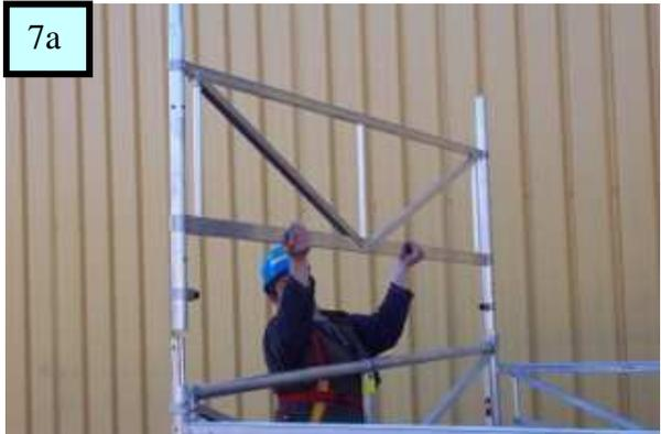
Positionner le 1er plateau dans l'axe de l'escalier d'accès ( fig. 7 )
