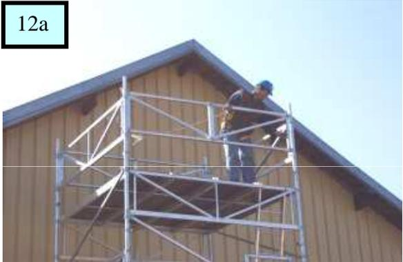
Terminer le montage de la tour avec les plinthes ( fig.13 et 13a )
