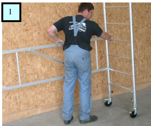
Fixer le CVZ 180/240 sur le 2ème et 4ème barreau de l'échelle EZ 175 S (fig. 1)
