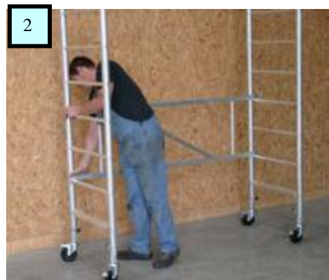
Fixer le CVZ 180/240 sur la 2ème échelle EZ 175 S (fig. 2)
